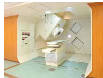
陽子線センター 回転照射室
